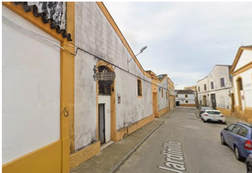
Fachada de las Bodegas Almodadén en la calle Jardinillo, 6
